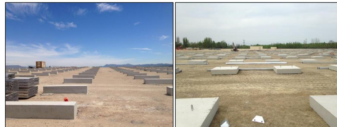
Figure 38 : Exemples d'utilisation de longrines béton sur les chantiers d'URBASOLAR à Fuveau (13) et Lavernose-Lacasse (31)
